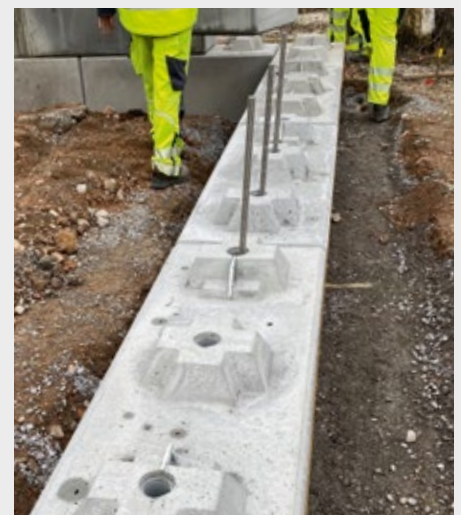
Aktivierung SwissBlock®-Systemmauer
